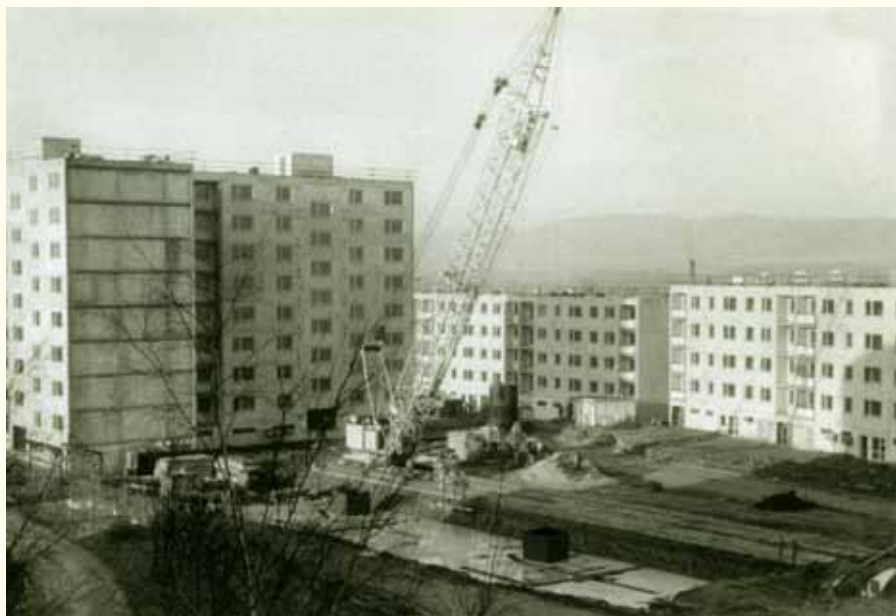
↑ Závěrečná fáze výstavby sídliště Hromůvka, zřejmě rok 1992 – stavba byla dokončována v době, kdy už byla panelová výstavba celospolečensky považována za překonanou.
